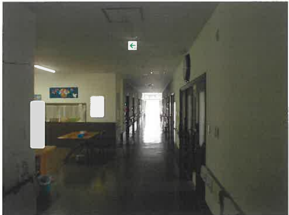
物件3 廊下からホール方向
