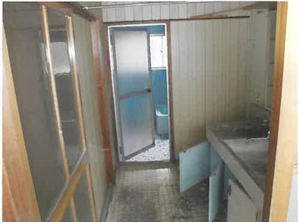
物件2 洗面所脱衣室と浴室
